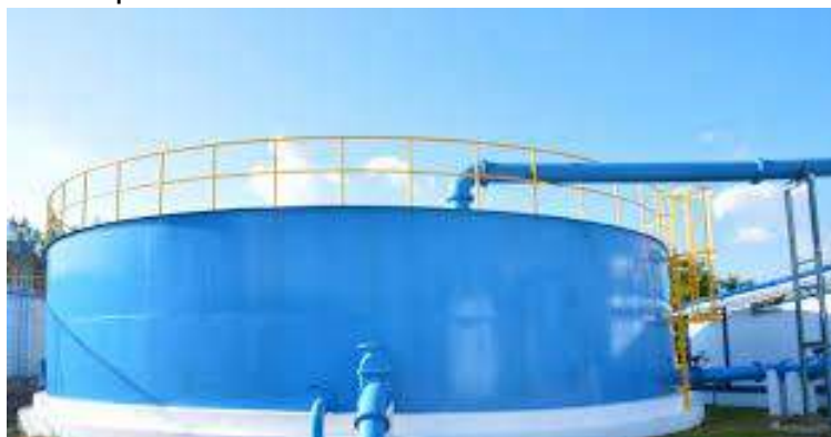
Reservatório de água
