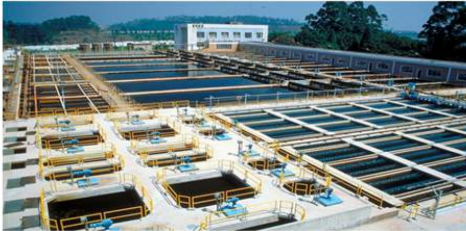
Imagem de uma estação de tratamento de água
