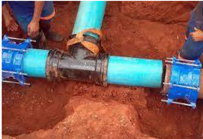
Obras de reparo em ramal domiciliar
